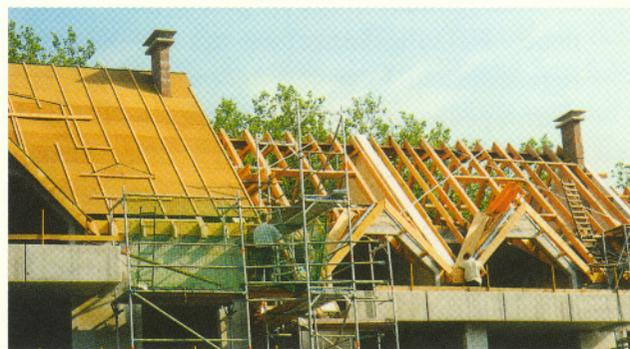
Der Aufwärtstrend des Daches geht synchron mit dem Aufschwung des Zimmerhandwerks. Unser Zimmerei- und Holzbaubetrieb entwickelt mit dem Architekten und Tragwerkplaner die Konstruktion, und fertigt die Teile der Holzkonstruktion mit modernen Maschinen und Anlagen wetterunabhängig und paßgenau vor. Teilweise entstehen in der Halle bereits komplette flächige Dachelemente, die den Ablauf weiter rationalisieren.
