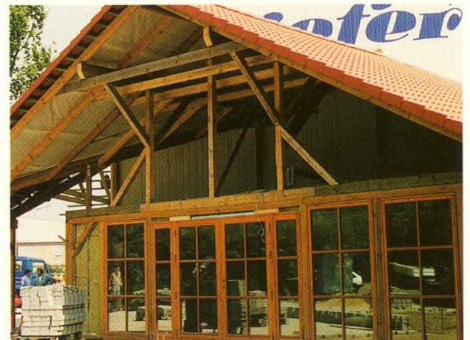
Auf der Baustelle montieren die Zimmerleute die Elemente mit Hilfe eines Krans. Durch genaue Vorfertigung und Ablaufplanung läuft die Millimeterarbeit reibungslos. Der Ingenieurholzbau zeigt schon als Rohbau seine Schönheit und Eleganz.
